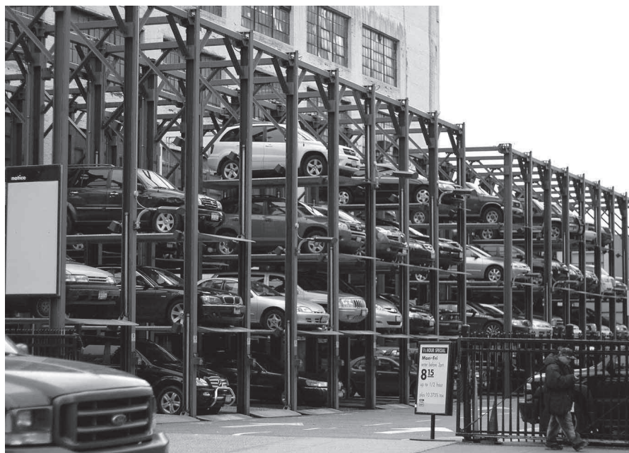
Aparcament en què es comparteixen les places d'estacionament per augmentar-ne la rendibilitat.
